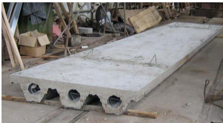
Рис. 4. Пустотно-ребристая плита размером 1000х6000 мм после изготовления и распалубки
