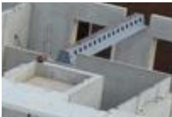
Рис. 1. Установка сталебетонной балки в крупнопанельном здании с последующим монтажом на балку пустотных плит [1]
