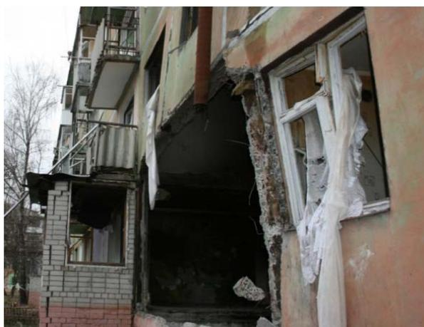
Рис. 2. Отклонение от проектного положения и обрушение трехслойных стеновых панелей и плит перекрытий в панельном доме серии 1-464 А после взрыва газа
