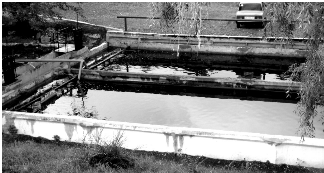
Рисунок 5 – Блок обеззараживания на Вергунских очистных сооружениях (фото Цыбы Н.)
