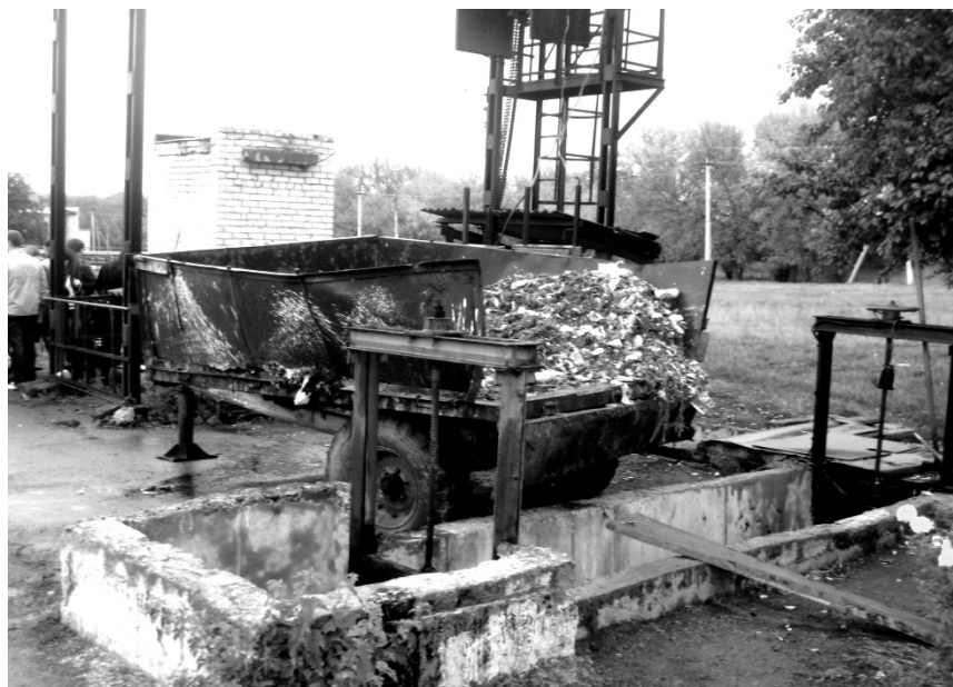
Рисунок 1 – Начальный этап механической очистки сточных вод на Вергунских очистных сооружениях (г. Луганск) – решетка (фото Цыбы Н.)
